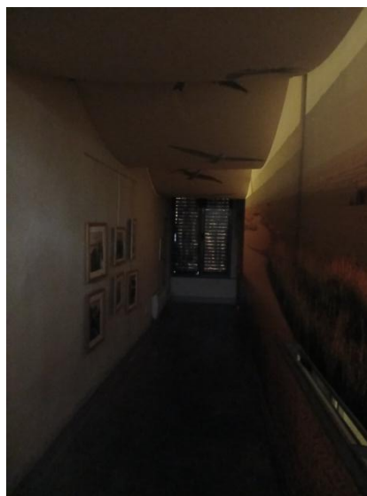
Absence d'éclairage de circulation de au moins 100 Lux
