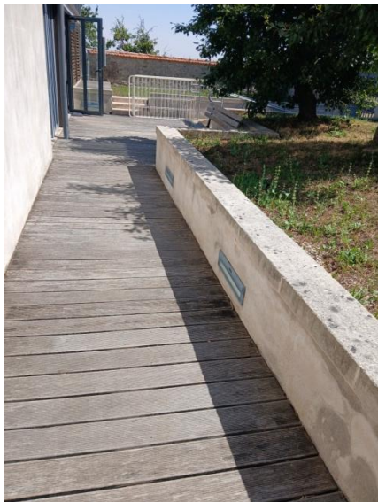
Eclairage du cheminement extérieur
