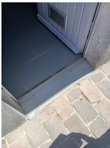
Installation du chanfrein
