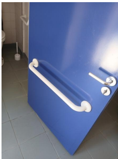
Installation d'une barre de tirage
