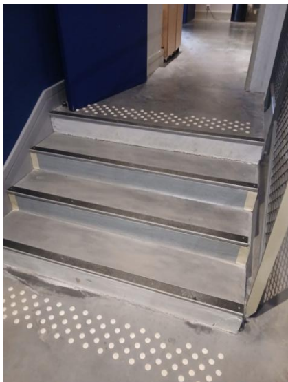
Les nez de marches des escaliers intérieurs contrastés
